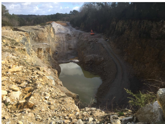
Le fond de fouille avec la pompe de reprise
