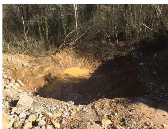
Le bassin de rétention amont
