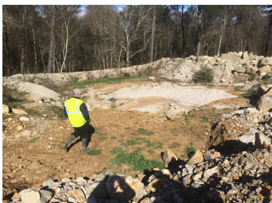
Le bassin d'infiltration
